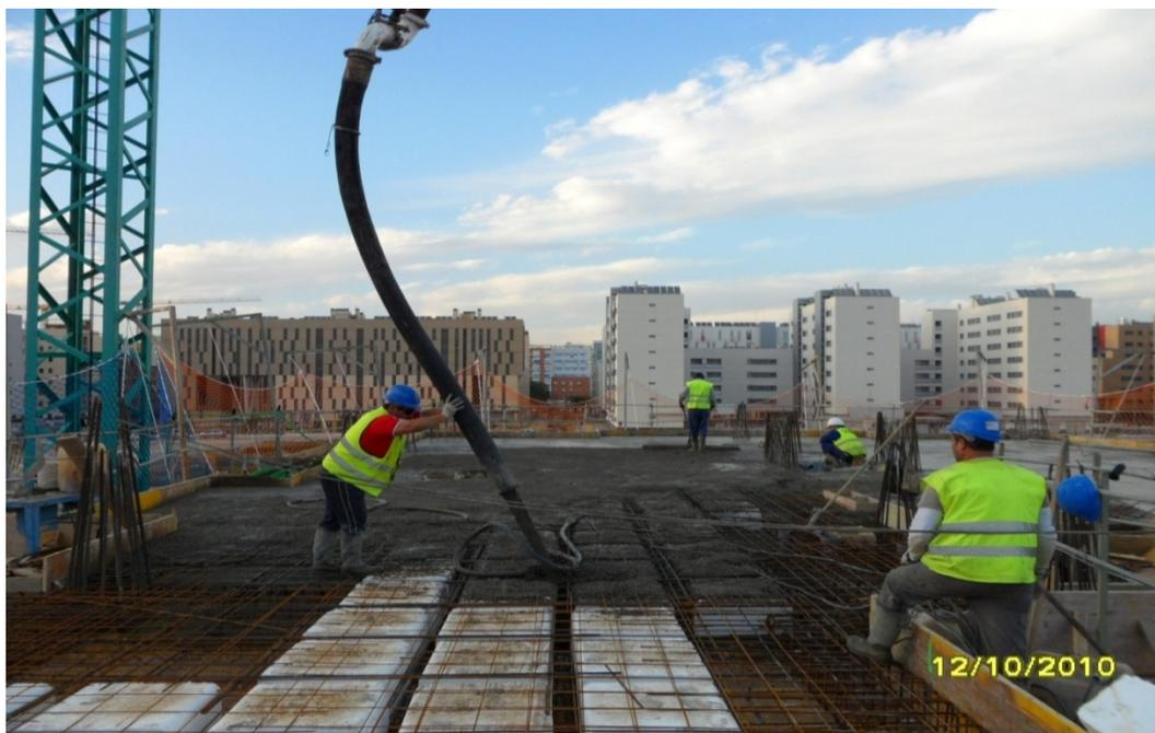
Fig. 68: Proceso de ejecución de forjados. Fase de hormigonado con bomba. Fuente Ferrovial Agromán.
