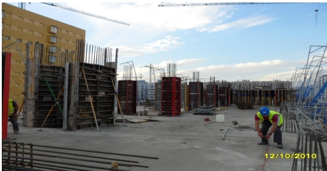
*Fig. 65: Proceso de ejecución de pilares. Fuente Ferrovial Agromán.*
