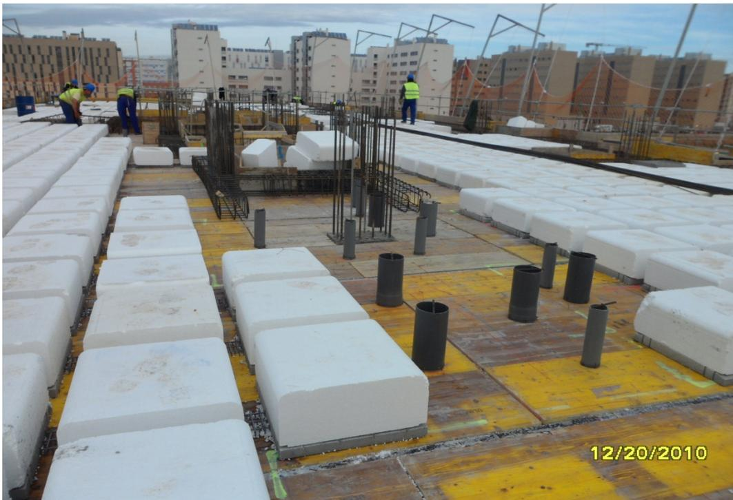
Fig. 67: Proceso de ejecución de forjado. Fase montaje de bloque y armaduras. Fuente Ferrovial Agromán.
