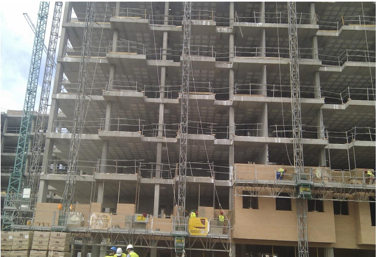
*Fig. 74: Colocación de barandillas de protección. Fuente Ferrovial Agromán.*
