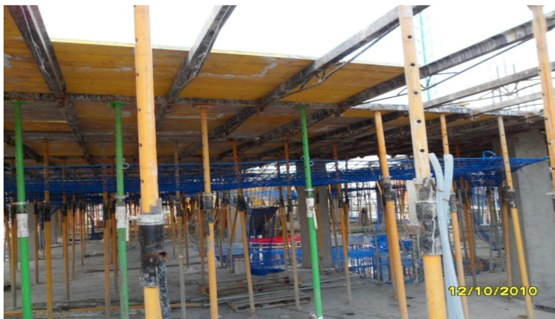
*Fig. 66: Proceso de ejecución de forjado. Fase de montaje de encofrado. Fuente Ferrovial Agromán.*
