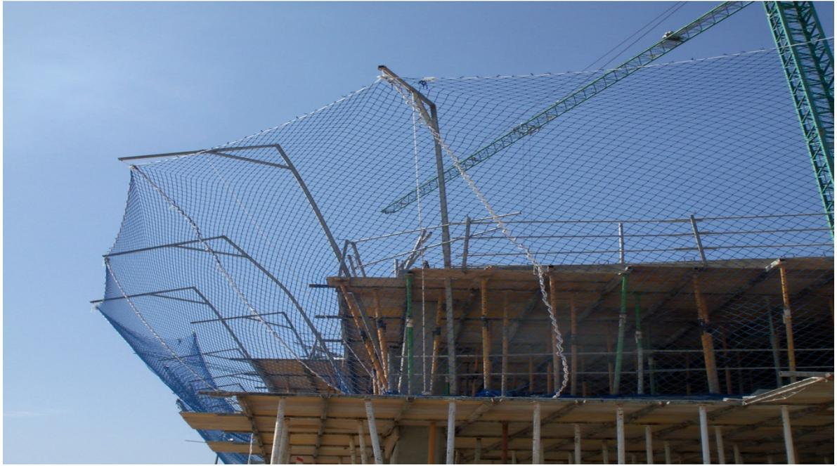
*Fig. 73: Colocación de redes verticales. Fuente Ferrovial Agromán.*
