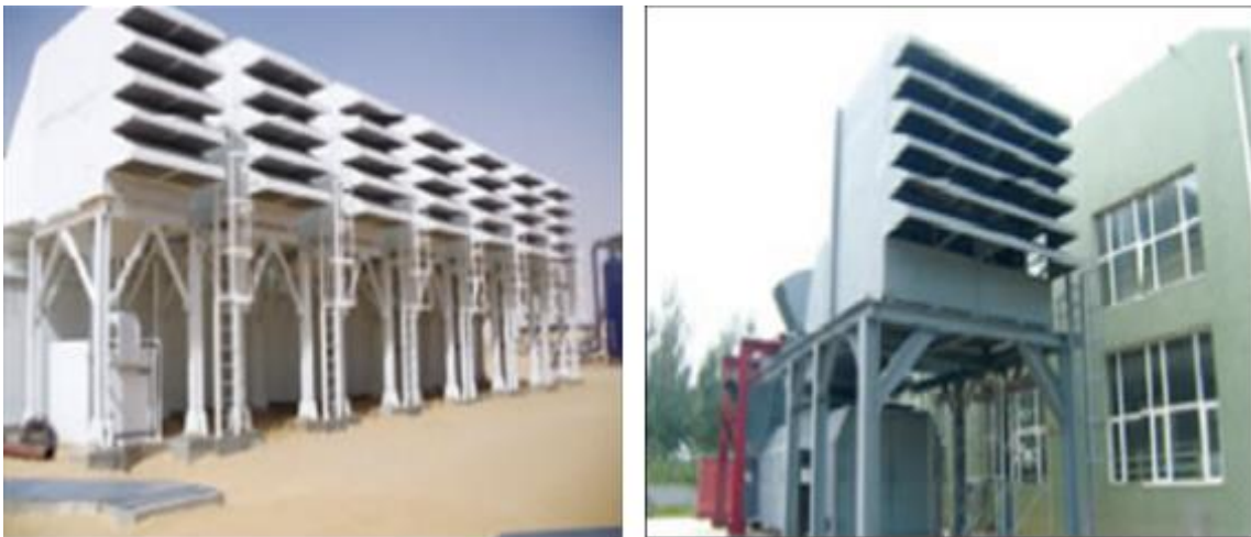
Figura 10. Cubiertas exteriores. Cortesía de Chenglin Technology Co.
