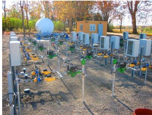
Figura 6: Banco de ensayo de Aula Dei
