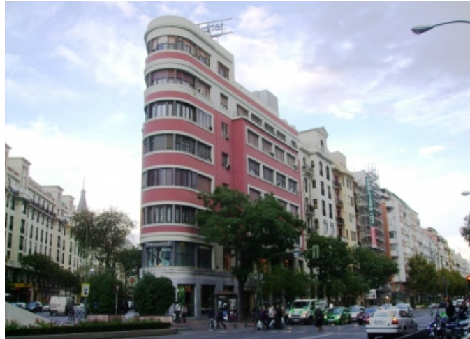
Figura 12. Visión lateral del edificio Castaño.
