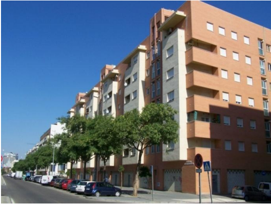
Fig. 1. Vista de la fachada oeste
