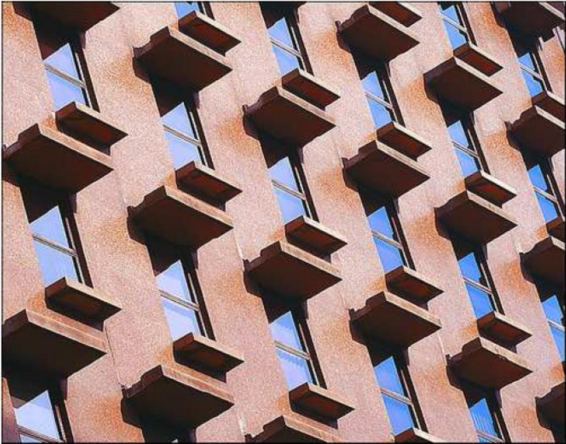
Figura A4.15: Fotografía de un edificio alemán con ventanas solares
