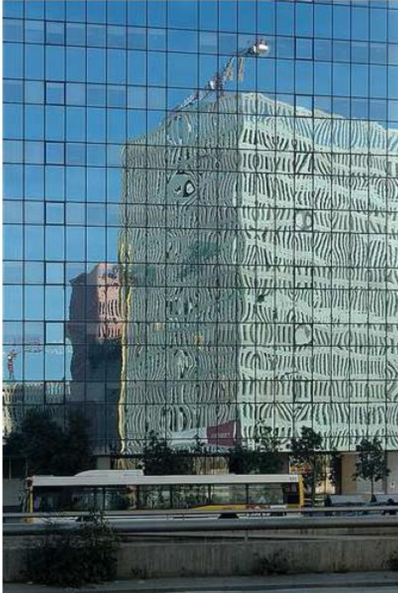
Figura A4.18: Edificio con ventanales formados por paneles solares
