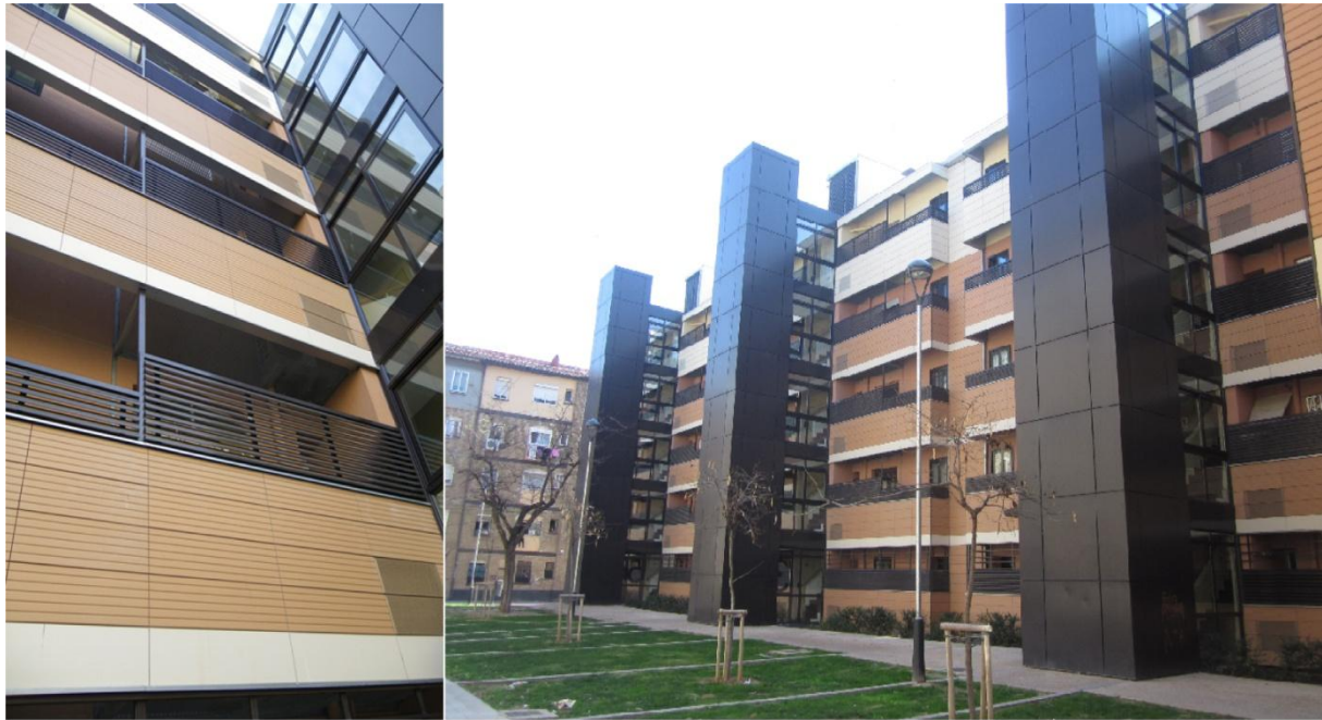
Figura 3. Edificio rehabilitado del Grupo Girón de Zaragoza.
