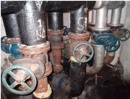
1.15 Bombas de condensados
