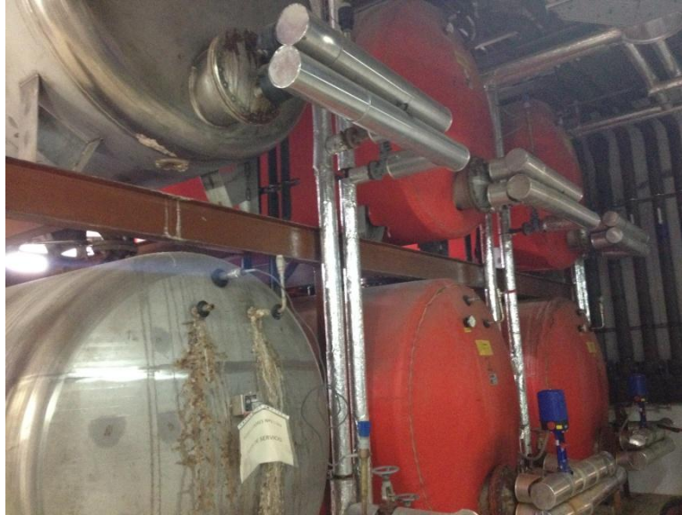
Figura 1.8 Depósitos de acumulación.
