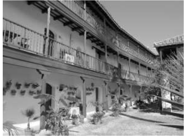
Vista de una de las fachadas interiores
