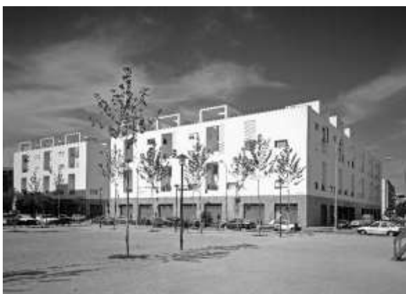
Vista de la manzana-patio desde la calle Blanco White
