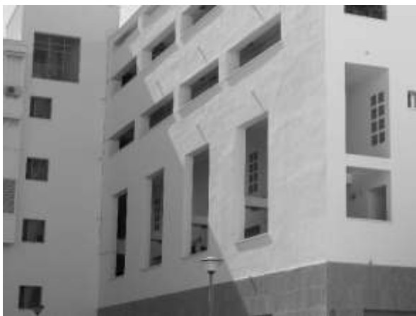
Fachada interior: galerías y núcleo de circulación
