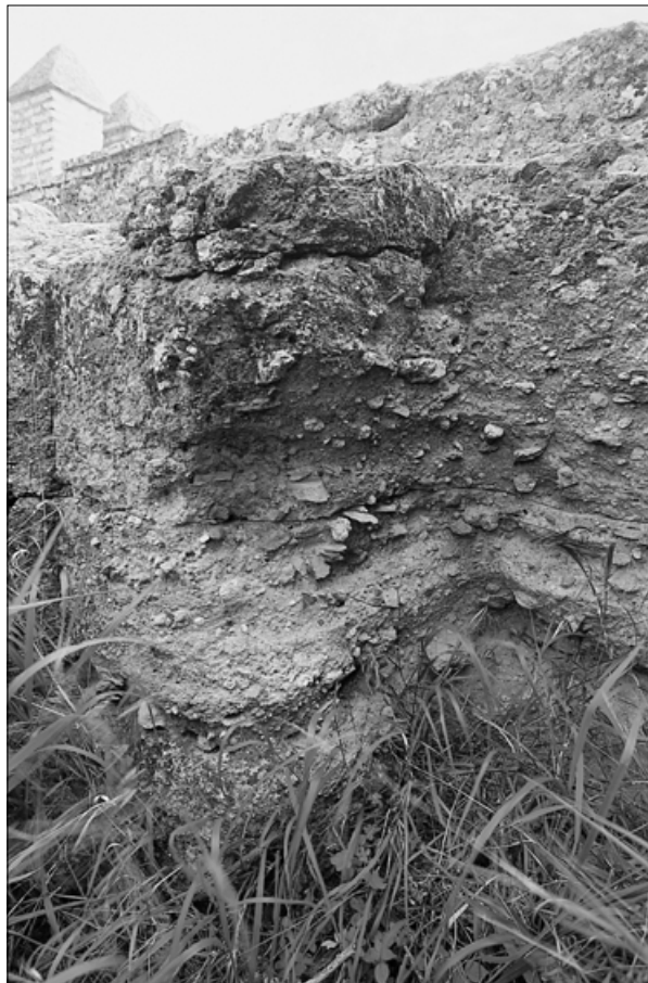
Fig. 7 Aspecto de la muralla (tapial) en el adarve norte.
