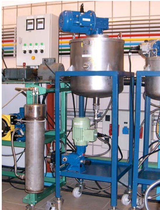
Figura III.84. Reactor de complejación y tanque de descarga del filtro
