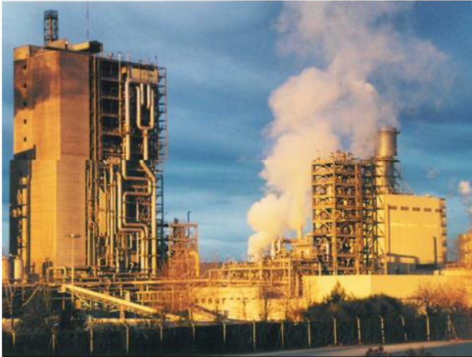
Figura I.5. Vista de la central GICC de ELCOGAS en Puertollano
