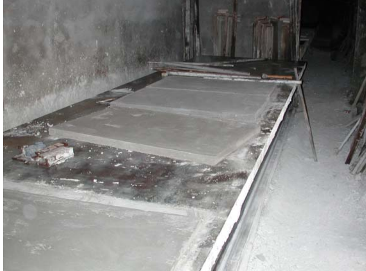
Figura 6.21 Desmoldado del material
