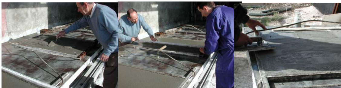
Figura 6.20 Alisado de la superficie de la placa
