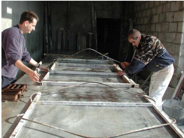
Figura 6.16 Colocación del molde de la placa
