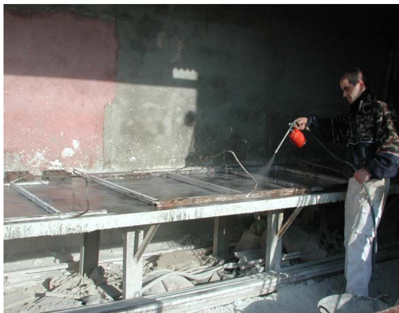
Figura 6.17 Adición de desencofrante en el molde
