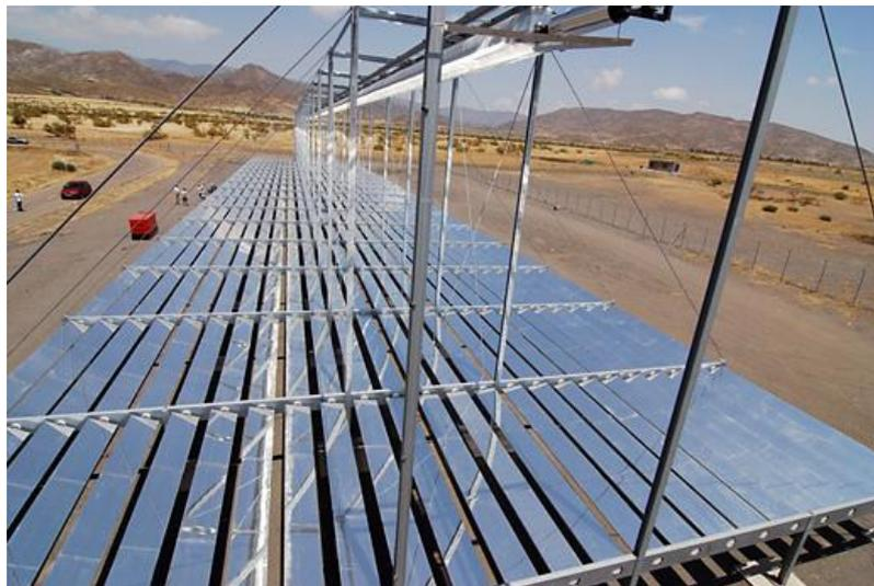
Figura 4. Colector demostración Fresnel lineal MAN, Plataforma Solar de Almería (PSA) [5]
