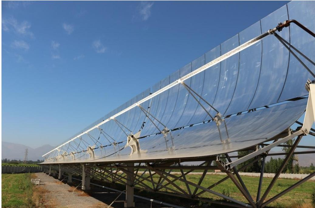
Figura 5. Captadores cilindro-parabólicos con seguimiento solar, JUCOSOL, San Flipe, Chile [6]
