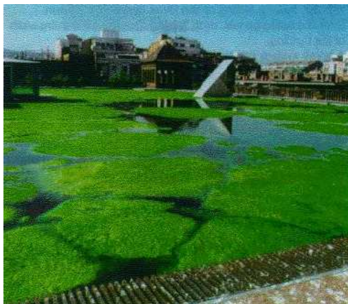
Figura 4.1. Vista del estanque sobre la cubierta de la biblioteca de la Universidad Pompeu Fabra en Barcelona.
