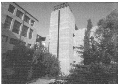
Figura 6.6. Edificio que usa ventilación natural situado en los alrededores de Atenas.
