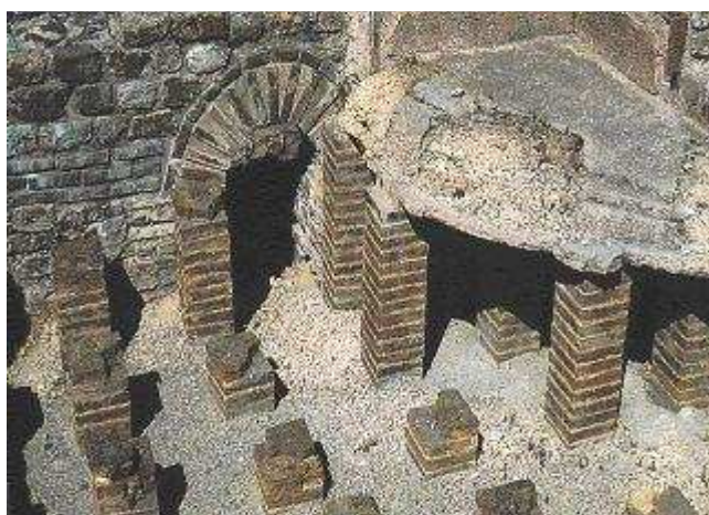
Figura 3.3. Detalles de hipocaustos. Construcción basada en apilamiento de piedras.
