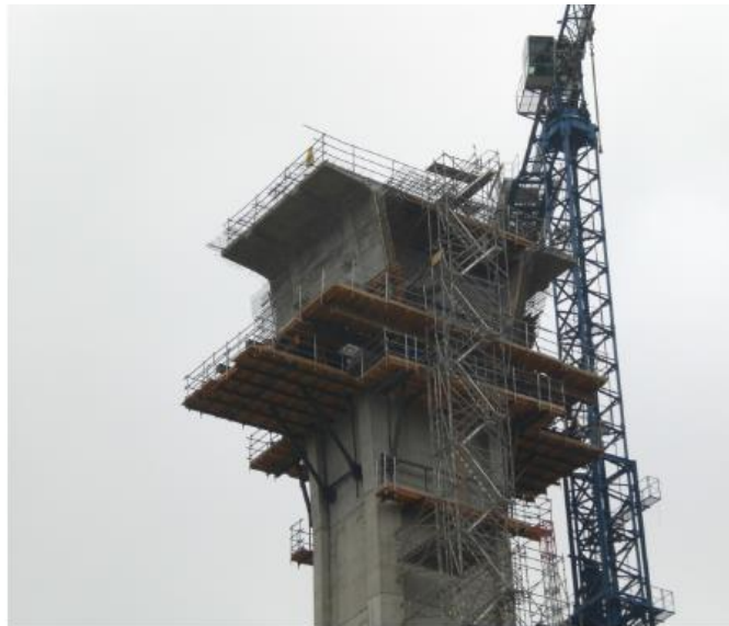
Fig 6. Hormigonado de la losa superior de la dovela "0"
