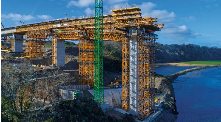
Fig 13. Construcción de puente por medio de torres y cerchas. Fuente [5]
