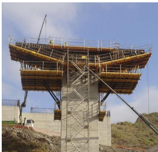
Fig 4. Encofrados dovela "0"
