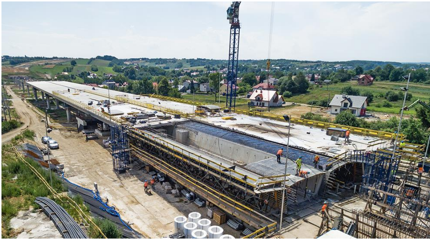
Fig 28. Parque de fabricación de dovelas.
