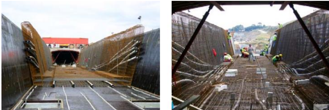
Fig 25. Introducción de las vainas de pretensado. Fuente [19]
