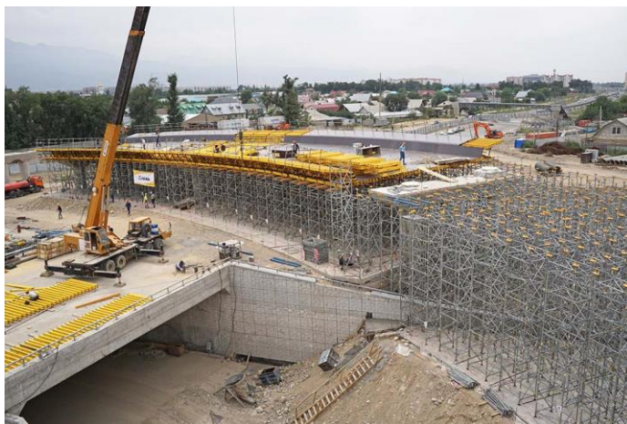
Fig 12. Puente ejecutado por cimbra cuajada
