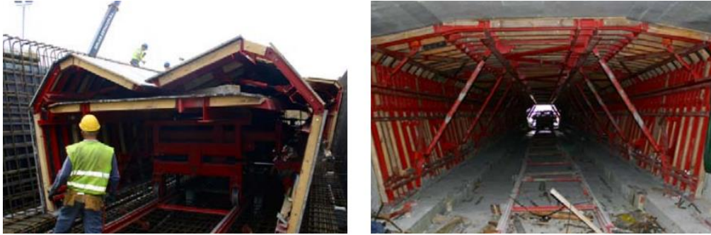
Fig 24. Encofrado interior plegable. Fuente [19]
