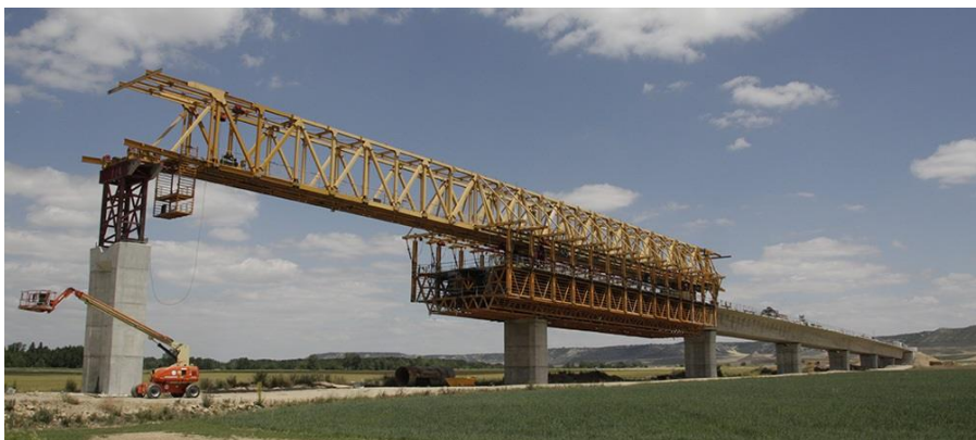
Fig 14. Ejecución de puente por autocimbra. Fuente [13]
