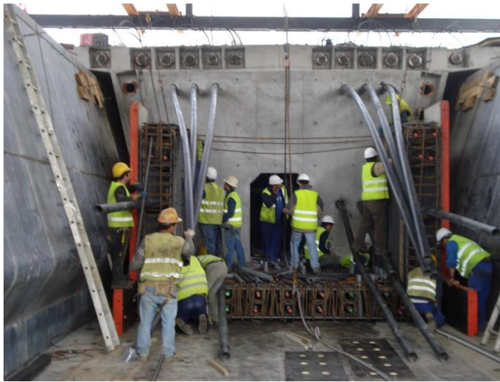
Fig 35. Tesado de la mitad de los tendones
