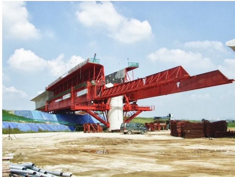
Fig 20. Cimbra autoportante bajo tablero [5]
