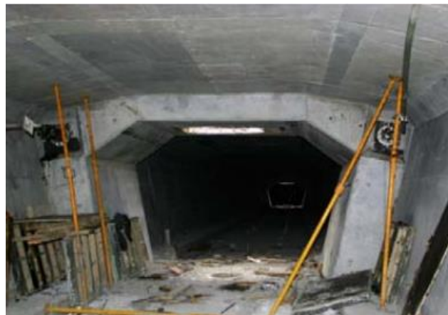
Fig 15. Ejecución de solapes en el ensanche del alma. Fuente [19]
