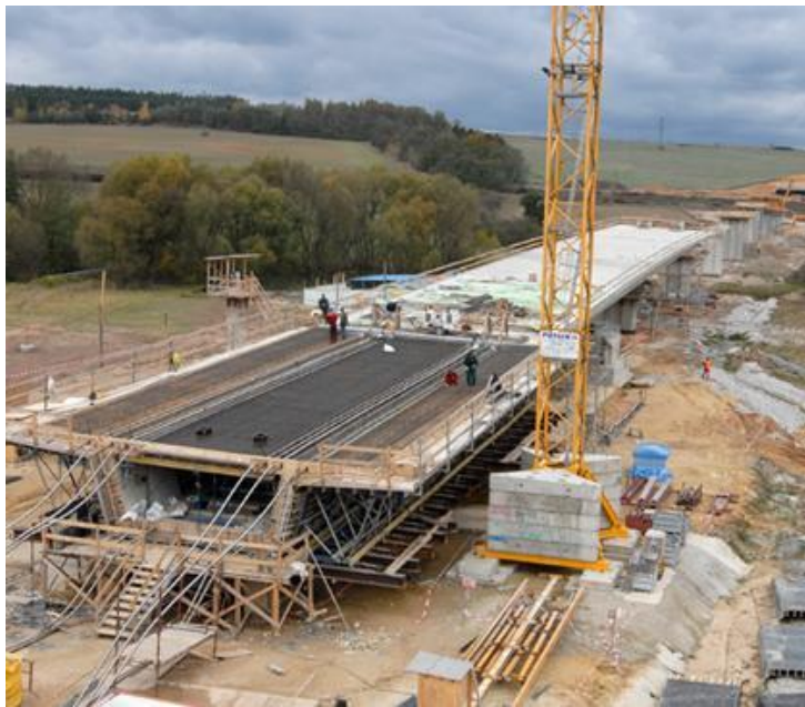
Fig 34. Ejecución del tablero superior
