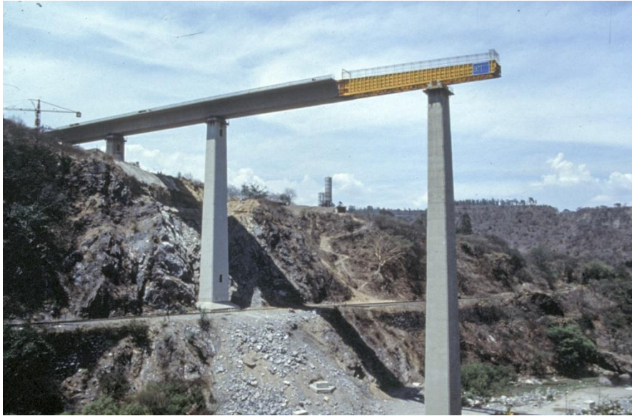
Fig 26. Ejecución de un puente por lanzamiento incremental.
