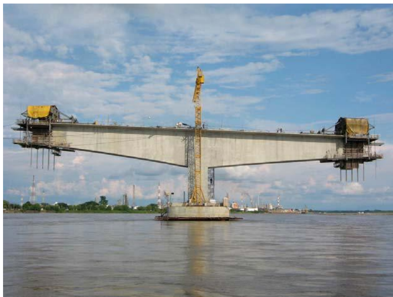
Fig 1. Construcción por voladizos sucesivos
