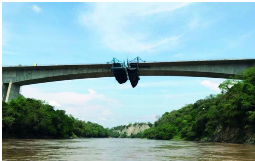
Fig 11. Ejecución de las dovelas de cierre
