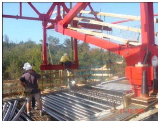
Fig 10. Colocación de las vainas en la losa superior
