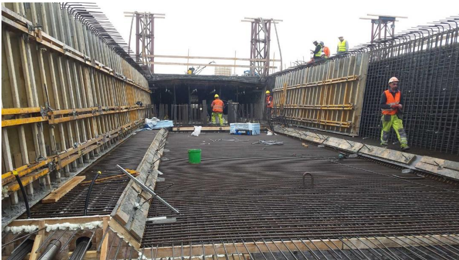
Fig 33. Ecofrado de las almas y colocación de la ferralla
