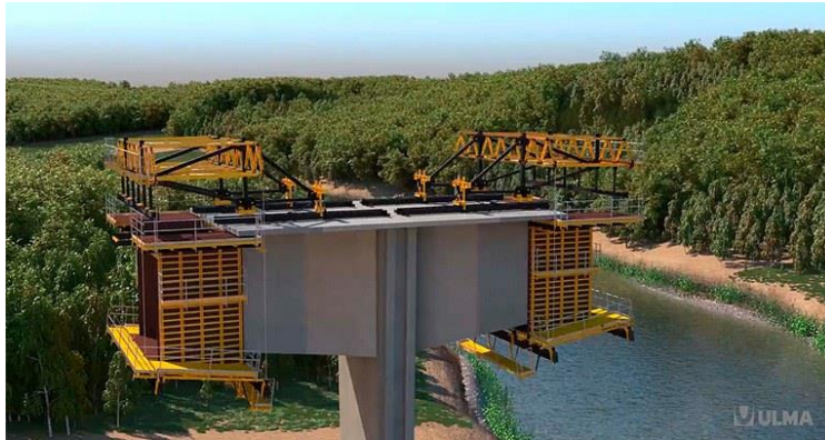
Fig 9. Encofrado y ejecución de la primera dovela. Fuente [5]
