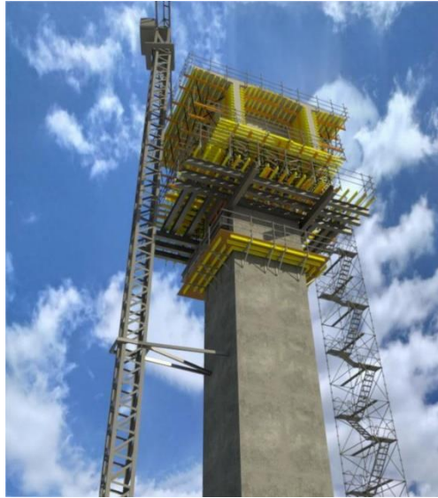
Fig 5. Hormigonado diafragmas dovela "0"
