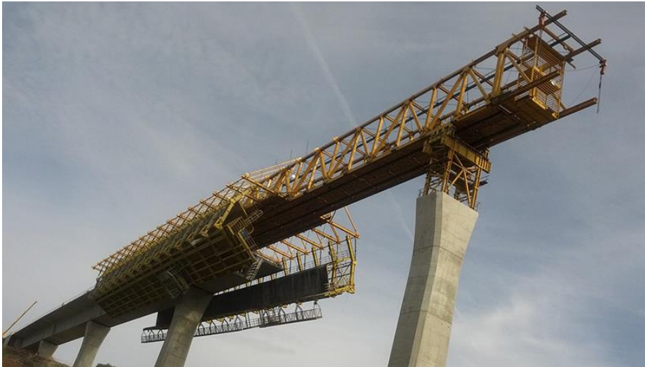
Fig 21. Cimbra autoportante sobre tablero
