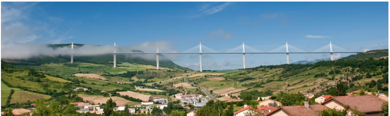
Fig 1.1. Viaducto de Millau, Francia, Valle del Tarn
