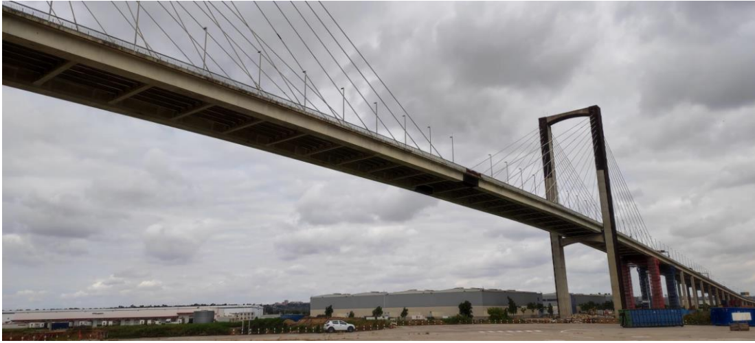
Fig 1.2. Puente del Centenario, España, Sevilla
