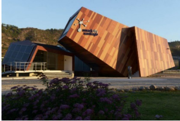
Figura 3. Edificio Smart Grid.
