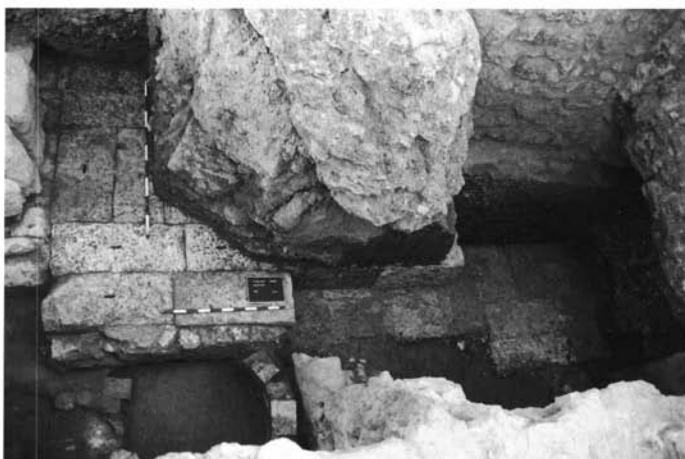
Lám. VI. Estructura de sillares en roca alberiza encargada de soportar los empujes del muro de San Antonio.
