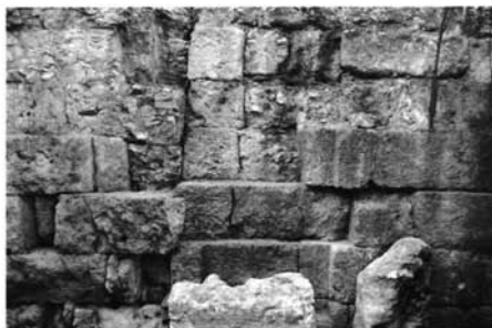
Lám. V. Detalle del muro oeste del iter sur allí donde se adosan los paramentos de sus fases I y II.
