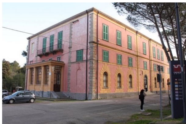
Figura 19. Palacio de la dirección, Montevecchio (Foto Mossa)
