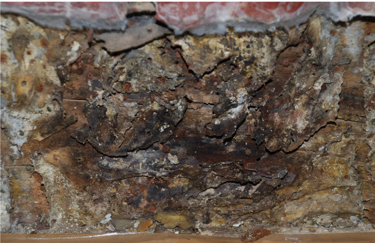
Pudrición en la madera soporte de una de las pinturas de la Sala de los Reyes de la Alhambra de Granada | foto Fondo Gráfico IAPH (Víctor Menguiano Chaparro)
