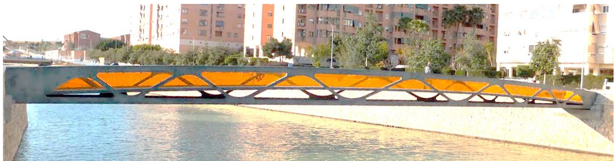
Figura 1-4. Pasarela Barranco de las Ovejas
