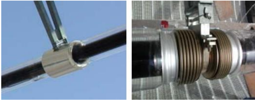
Figura 2-16. Unión del elemento bracket al tubo receptor [15].
