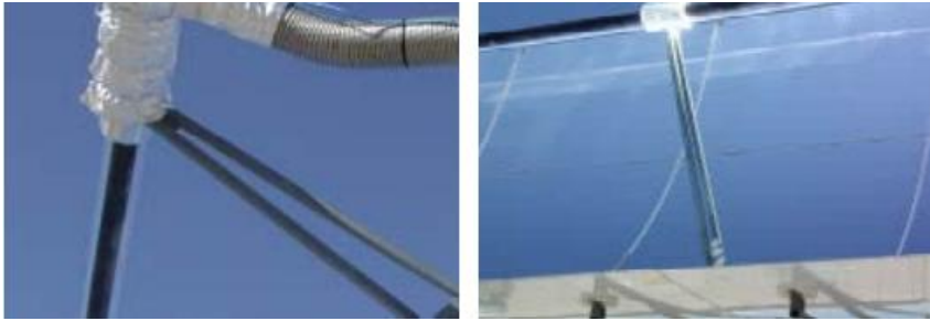
Figura 2-15. Ejemplos del elemento bracket que soporta el tubo receptor [15].
