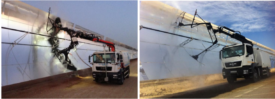
Figura 2-21. (a) Limpieza con agua a presión y cepillado; (b) Limpieza con agua a presión [43].
